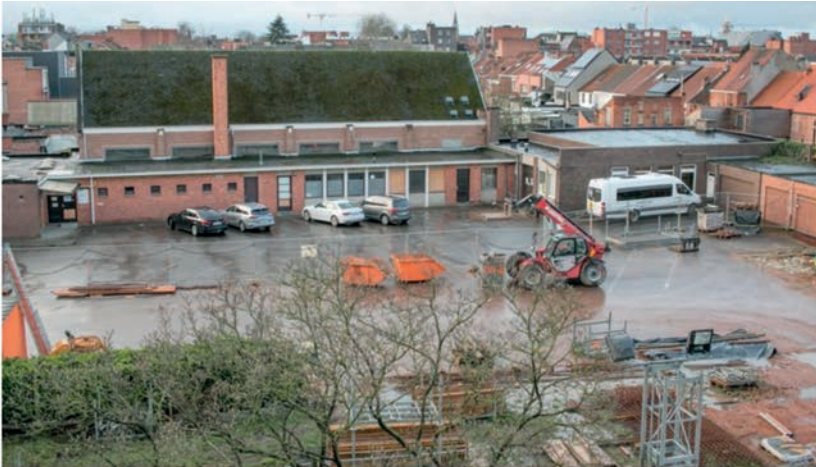
Zaal Familia op de Paterssite wordt afgebroken om plaats te maken voor een coöperatief woonproject. © JVS
