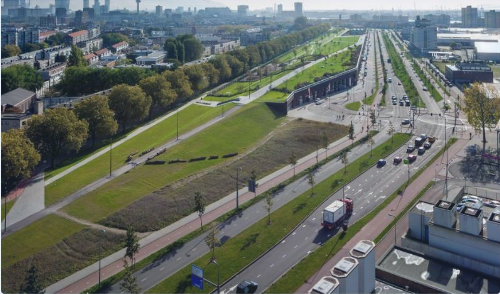
📷 Figuur 1. Het Dakpark in Rotterdam is een multifunctionele waterkering waarbij winkels, parkeerplaatsen en een park in een dijk zijn geïntegreerd
